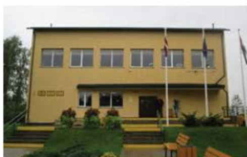
2.20. ATTĒLS: Pašvaldības ēka ar zemu īpatnējo siltumenerģijas patēriņu – atjaunotā Sēlpils pagasta pārvaldes un kultūras nama ēka (85 kWh/m²)
