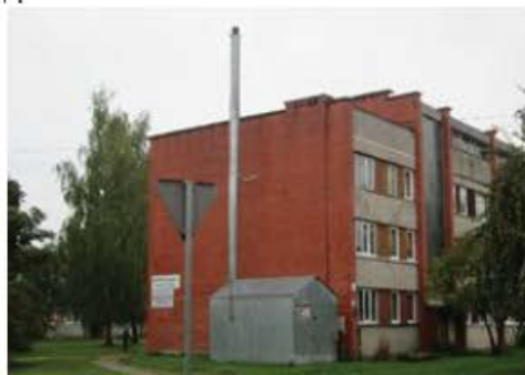
2.6. ATTĒLS: Moduļu dabasgāzes katlu māja, kas apkurina dzīvojamā ēku Salas ciemā
