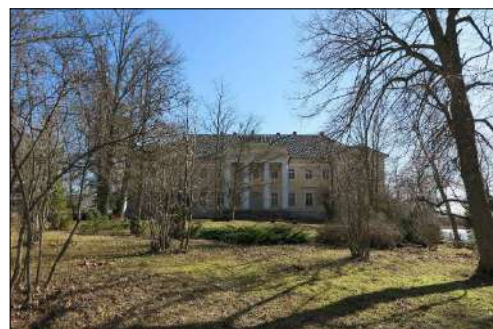
3. Iš parko atsiveriantis vaizdas į šiaurinį rūmų fasadą ir istorinį sodą. Fasadas ir medžių grupės struktūriškai išsaugotos geros kokybės. Sodo struktūrą galima nustatyti tik su pagalbinėmis priemonėmis, struktūra vidutinės kokybės. Iš dalies aukštas vaizdas.
