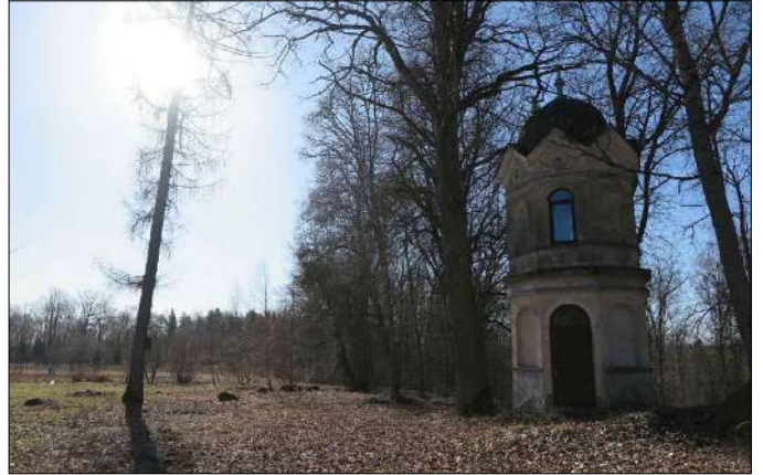
6. Parko paviljonas. Bokšte įstatyti nauji langai ir metalinės durys, apsaugančios nuo vandalizmo
