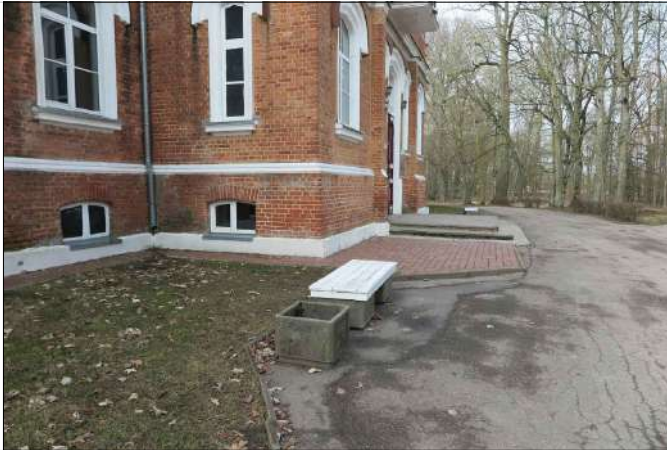
5. Elementai Mezmuižos pilies šiaurės rytų pusėje
