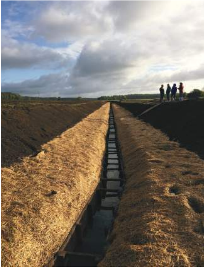
7. attēls. Divpakāpju grāvis - Sodītes ūdenstece Jelgavas novadā (Autors: Ainis Lagzdiņš).
