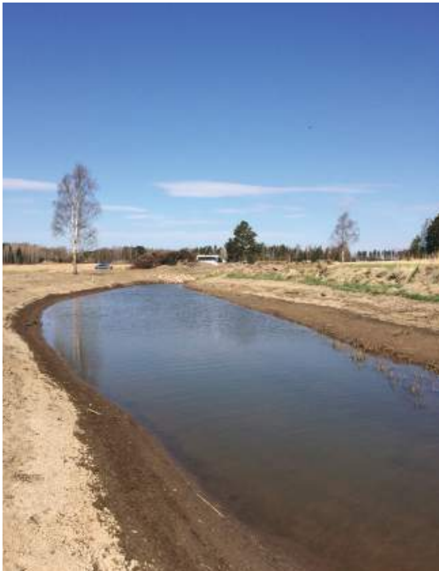
5. attēls. Sedimentācijas baseins - Hardombäcken ūdenstece Somijā (Autors: Ainis Lagzdīnš).
