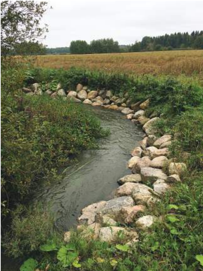
13. attēls. Ūdensteces meandrs ar akmeņu stiprinājumu nogāzē - Zviedrija (Autors: Ainis Lagzdiņš).
