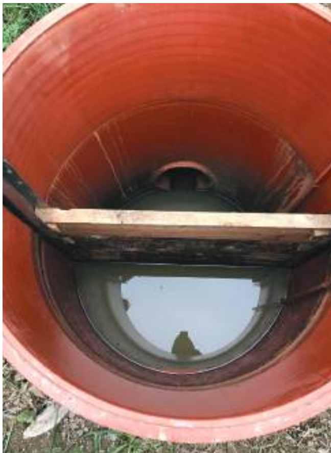
16. attēls. Kontrolaka ar manuāli regulējamiem aizvariem - Zviedrija (Autors: Ainis Lagzdīņš).
