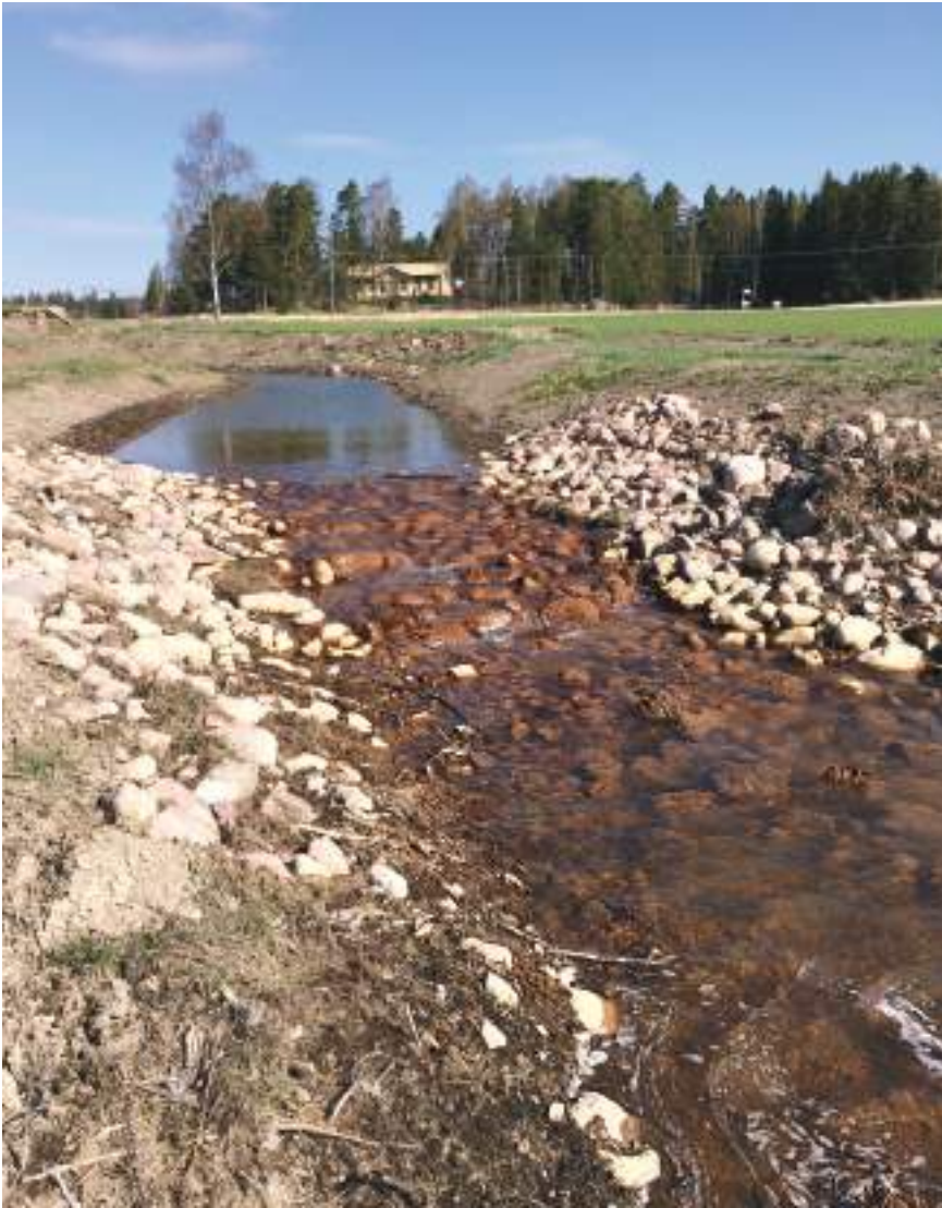
11. attēls. Akmeņu krāvums kombinācijā ar sedimentācija baseinu - Hardombäcken ūdenstece Somijā (Autors: Ainis Lagzdīņš).
