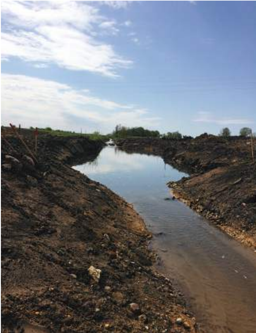
4. attēls. Sedimentācijas baseins - Ailes strauts Jelgavas novadā (Autors: Ainis Lagzdiņš).
