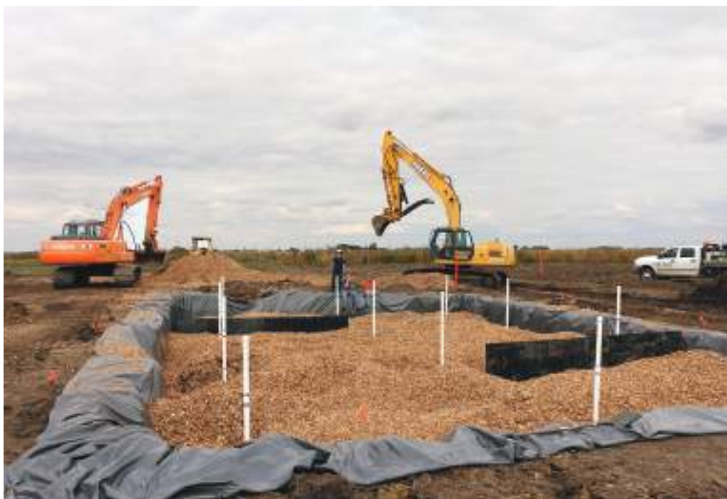
27. attēls. Koka šķeldas bioreaktors ar ūdens plūsmu regulējošām barjerām - ASV (Autors: Laura E. Christianson).
