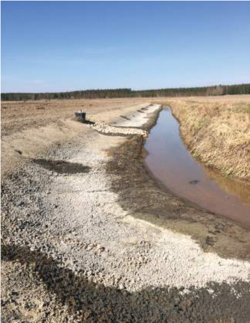
8. attēls. Divpakāpju grāvis - Hardombäcken ūdenstece Somijā (Autors: Ainis Lagzdīņš).
