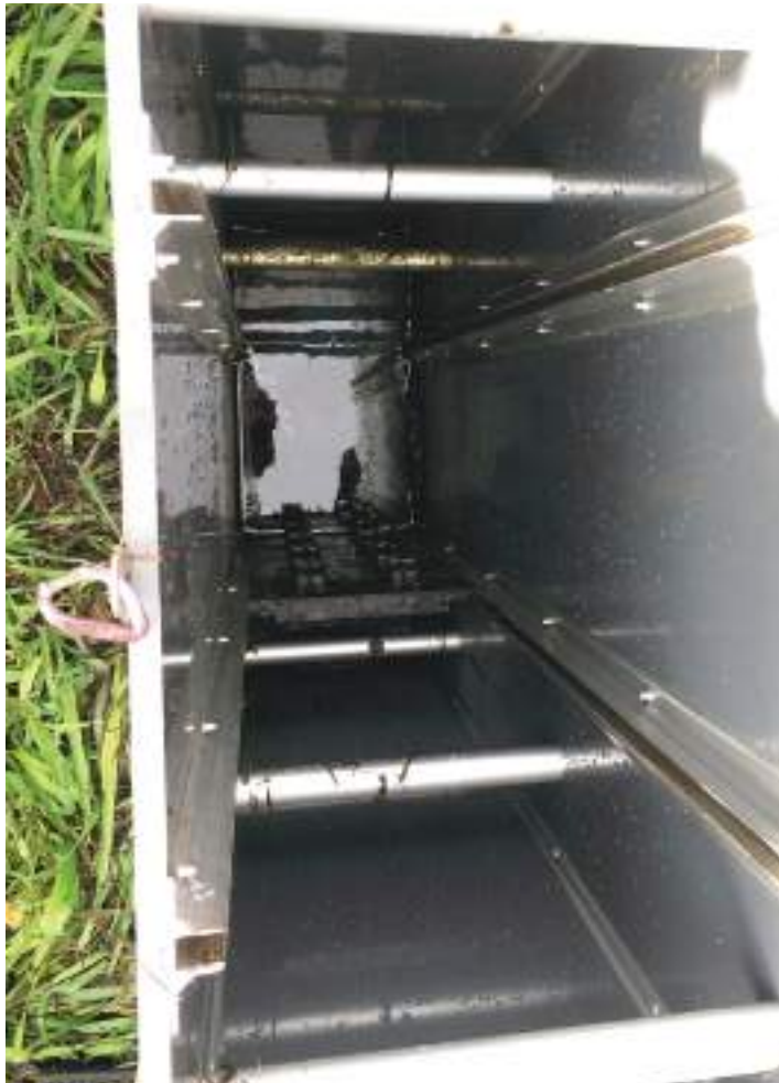
17. attēls. Kontrolaka ar manuāli regulējamiem aizvāriem - ASV (Autors: Ainis Lagzdīņš).
