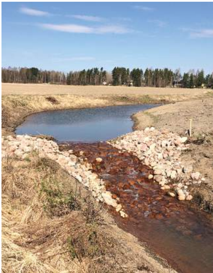
12. attēls. Akmeņu krāvums kombinācijā ar sedimentācija baseinu - Hardombäcken ūdenstece Somijā (Autors: Ainis Lagzdiņš).
