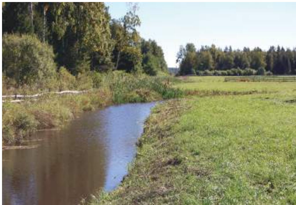
33. attēls. Kombinēti videi draudzīgi meliorācijas sistēmu elementi (sedimentācijas baseins un mākslīgais mitrājs) - dabas saimniecība “Lielkrūzes” (Autors: Ainis Lagzdiņš).
