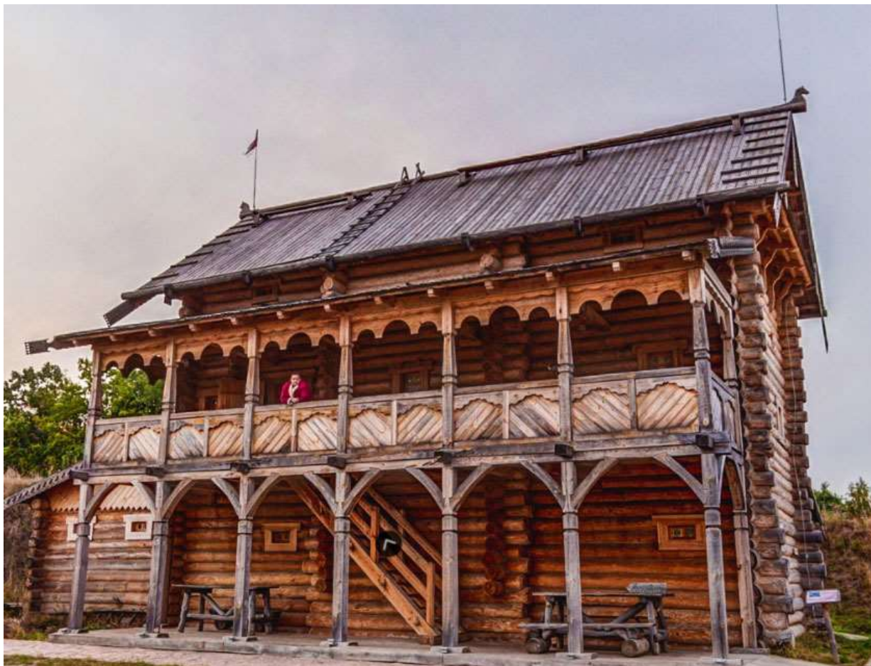
38.att. Valdnieka ēkas rekonstrukcija, senā Kijeva
